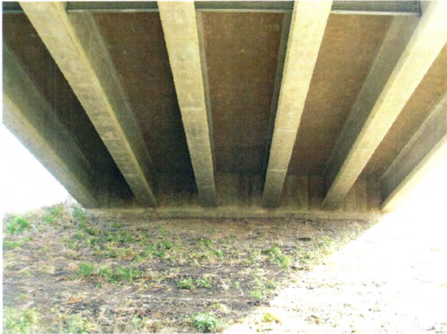
(d) Bottom view (abutment)
